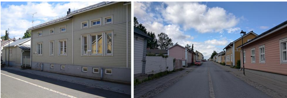
Kuva 9: Saaristokatu, jossa puukaupunkiympäristöön sovitettuja uudisrakennuksia. Uudisrakentamisessa toistuu uusklassisille ominainen koristelemattomuus, ruutuikkuna, mittasuhteet ja symmetria, jotka liittävät uudemmat osat hyvin vanhaan korttelikokonaisuuteen ja katujulkisivuun. Vanhasta rakennuskannasta poiketen uudisrakennukset ovat osittain 1 ½ -kerroksen korkuisia, mutta liittyvät luontevasti korttelin ja katutilan mittakaavaan.
