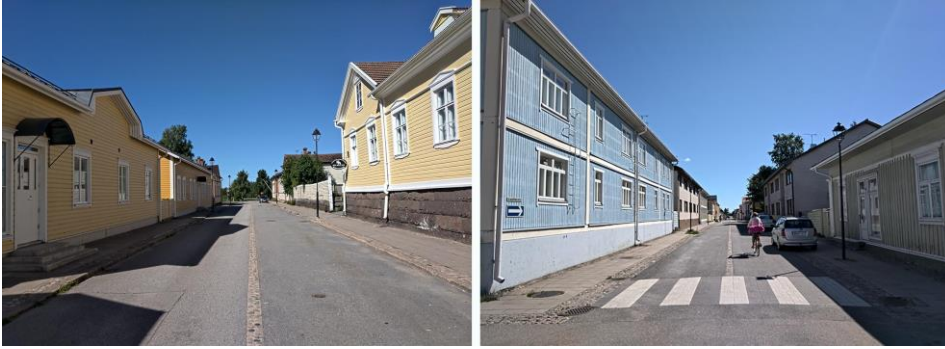
Kuva 8: Vasemmanpuoleisessa kuvassa Koulukadulta uudisrakentaminen on sovitettu materiaalien, mittakaavan ja massoittelemalla osalta ympäröivään rakennuskantaan. Oikeanpuoleisessa kuvassa Kauppakadulta uudisrakennusten materiaalit ja julkisivujen jäsenys pyrkivät noudattamaan vanhaa puukaupunkiperinnettä. Rakennusten mittakaava ja kerrosluku (täydet kaksi kerrosta) poikkeavat kuitenkin perinteisestä katutilasta, jossa matalat ja pääosin yksikerroksiset rakennukset reunustavat katuja.
