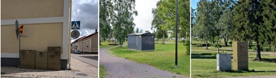
Kuva 20: Erilaiset tekniset rakenteet, kuten sähkökaapit ovat osa rakennettua kaupunkiympäristöä.
