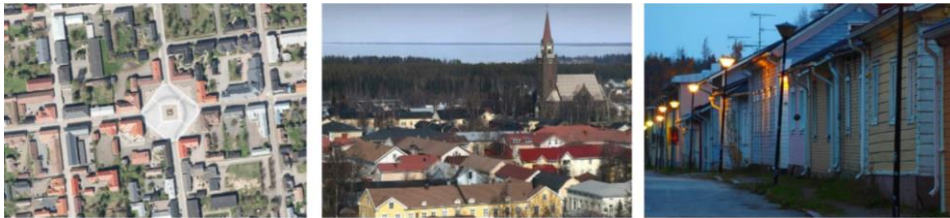
Kuva 3: Tarkastelualue muodostaa kaupunkirakenteellisesti helposti hahmotettavan ja tiiviin kokonaisuuden, joka erottuu selkeästi ympäröivistä alueista korttelirakenteen, rakennusten massoittelemalla, mittakaavan ja materiaalien osalta.
