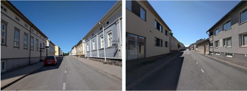
Kuva 30: Kaupunkikuvallisesti Vanhassa kaupungissa on pitkiä ja suorita katuosuuksia ja luontevia levähdys- tai oleskelupaikkoja on melko vähän. Parhaimmillaan pienet aukiotilat, julkisivun sisennykset, puistot ja kadun ”epäjatkuvuuskohdat” rikkovat suoraviivaista katutilaa, lyhentävät paikkojen välistä koettua etäisyyttä ja muodostavat kiinnostavaa kaupunkitilaa.
