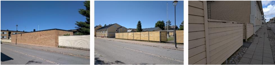
Kuva 17: Vasemmalla uudisrakentamiseen liittyvä piharakennus rajaa tiukasti katutilaa, mutta muodostaa materiaaleiltaan ja muotokieleltään vieraan elementin katutilaan. Keskellä: Harvalaudoitettu ja kevytrakenteinen aita, joka rajaa katutilaa, mutta jättää katujulkisivuun pitkän aukkokohdan. Oikealla: täydennysrakentamiseen liittyvä umpinainen aita, joka toistaa päärakennuksen väritystä ja rajaa katutilaa selkeästi.
