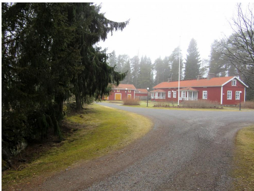
Kuva 23. Mutalan nykyistä uudistettua rakennuskantaa luoteeseen.
