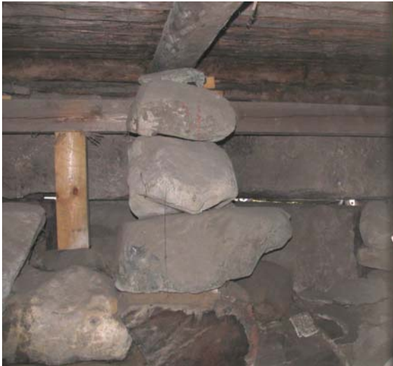
Alapohja on hyvin tuulettuva ja materiaalit ovat pääosin terveitä.
