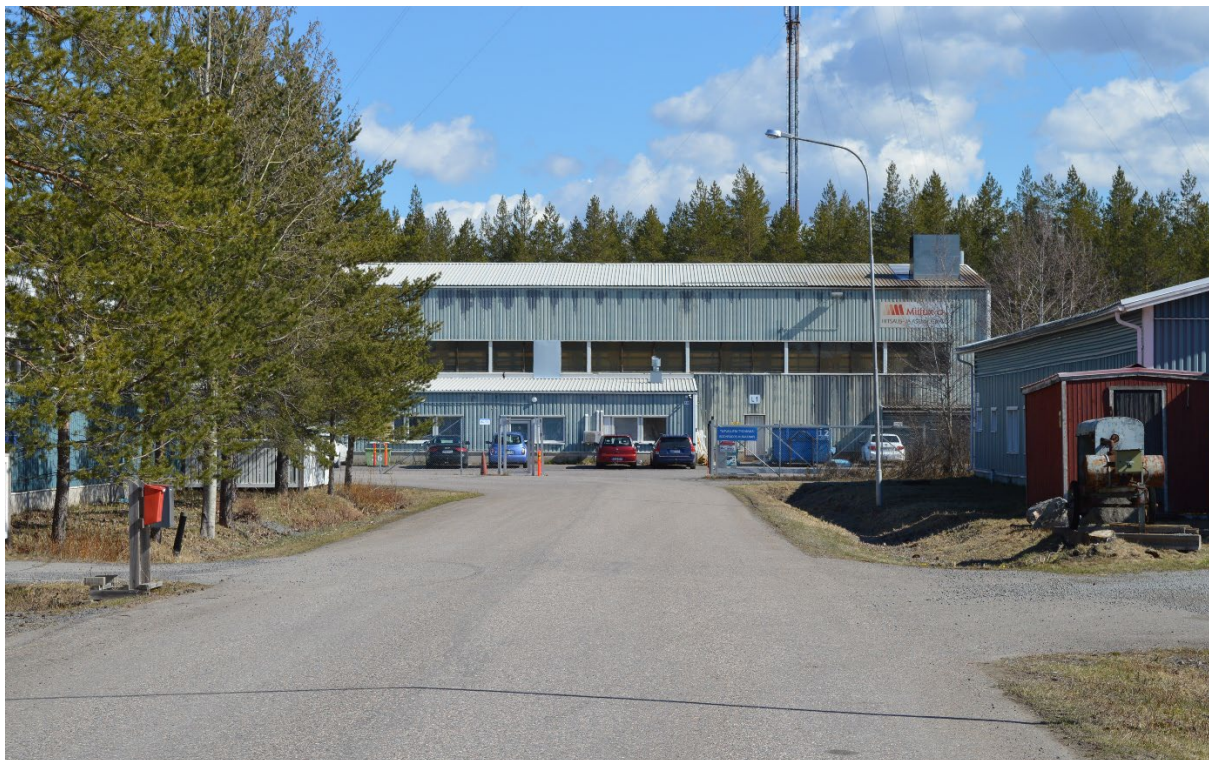
Kuva 9 Näkymä suunnittelualueelle Mestarinkatua pitkin koilliseen. Katunäkymän päätteessä on Miilux Oy. (Raahen kaupunki, O. Järvinen 2019.)
