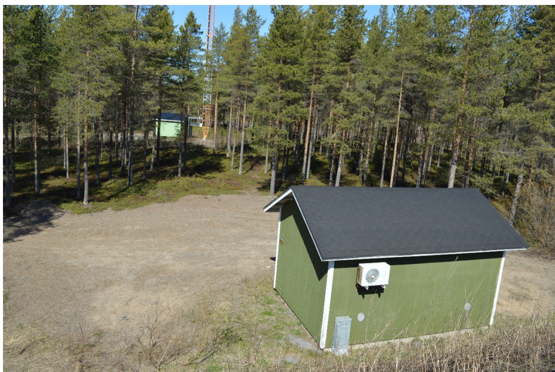
Kuva 11 Etualalla valtatie 8 varressa oleva pumppuasema. Taustalla teleliikennemasto ja sen huoltorakenteita. (Raahen kaupunki, O. Järvinen 2019.)
