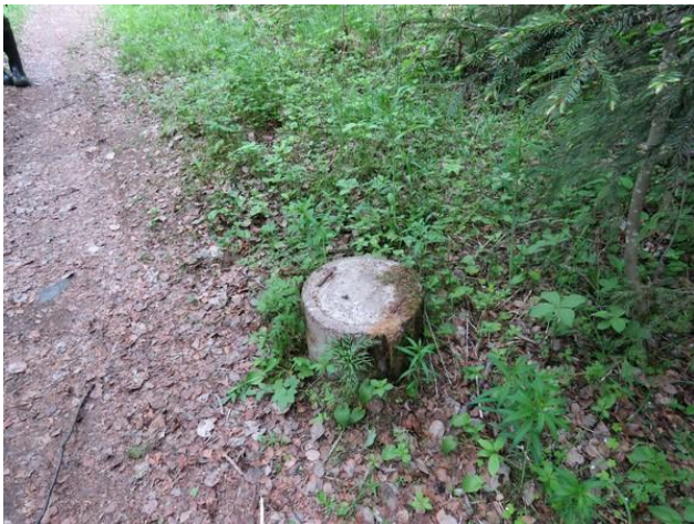
Hyppyrিতornin betonituki (yht. 3 kpl).
