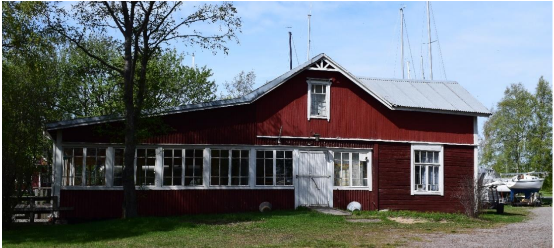
Kuva 52. Pursimajan kaakon julkisivu.
