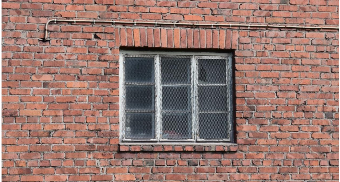
Kuva 6. Vanhan paloaseman tiililadontaa.
