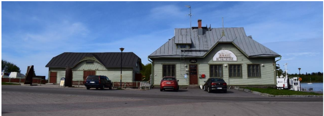
Kuva 12. Ruiskuhuone ja Pruutta.
