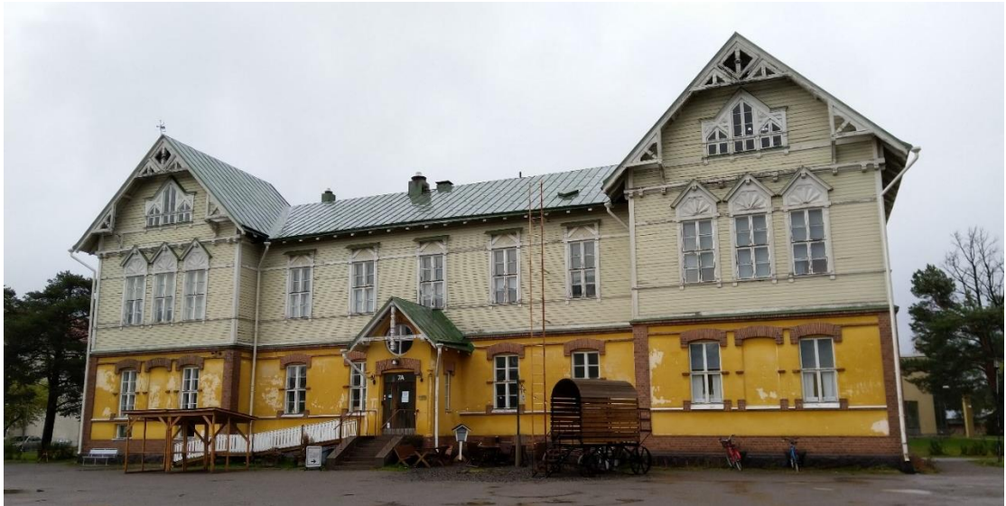
Kuva 17. Raahen seminaarin harjoituskoulurakennus (rakennus 7A).
